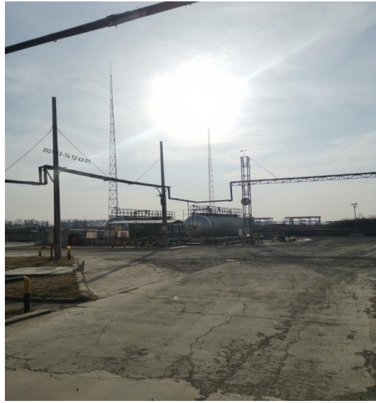
现场主要装置
